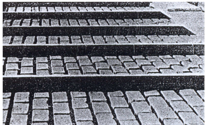
1. kép: Horcsik-födém betonozás előtti állapotban
