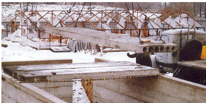
5. kép: PS födempalló beemelése
