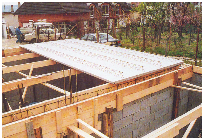
6. kép: Zsaluzó kéregpanel építés közben
