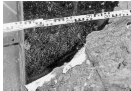
A fátyolinjektálás igazán hatásosan beszorított szigetelés mellett készíthető
