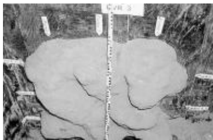
Lassan kötő anyaggal készült hátűrinjektálás, a kvázi-félgömb alakú, injektálóanyaggal átitatott talajtestek vastag, összefüggő réteget eredményeznek
