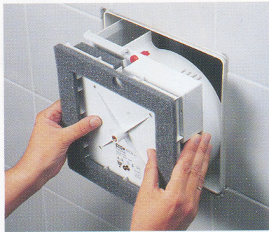
Csavar nélküli baonettzárás beépítés
