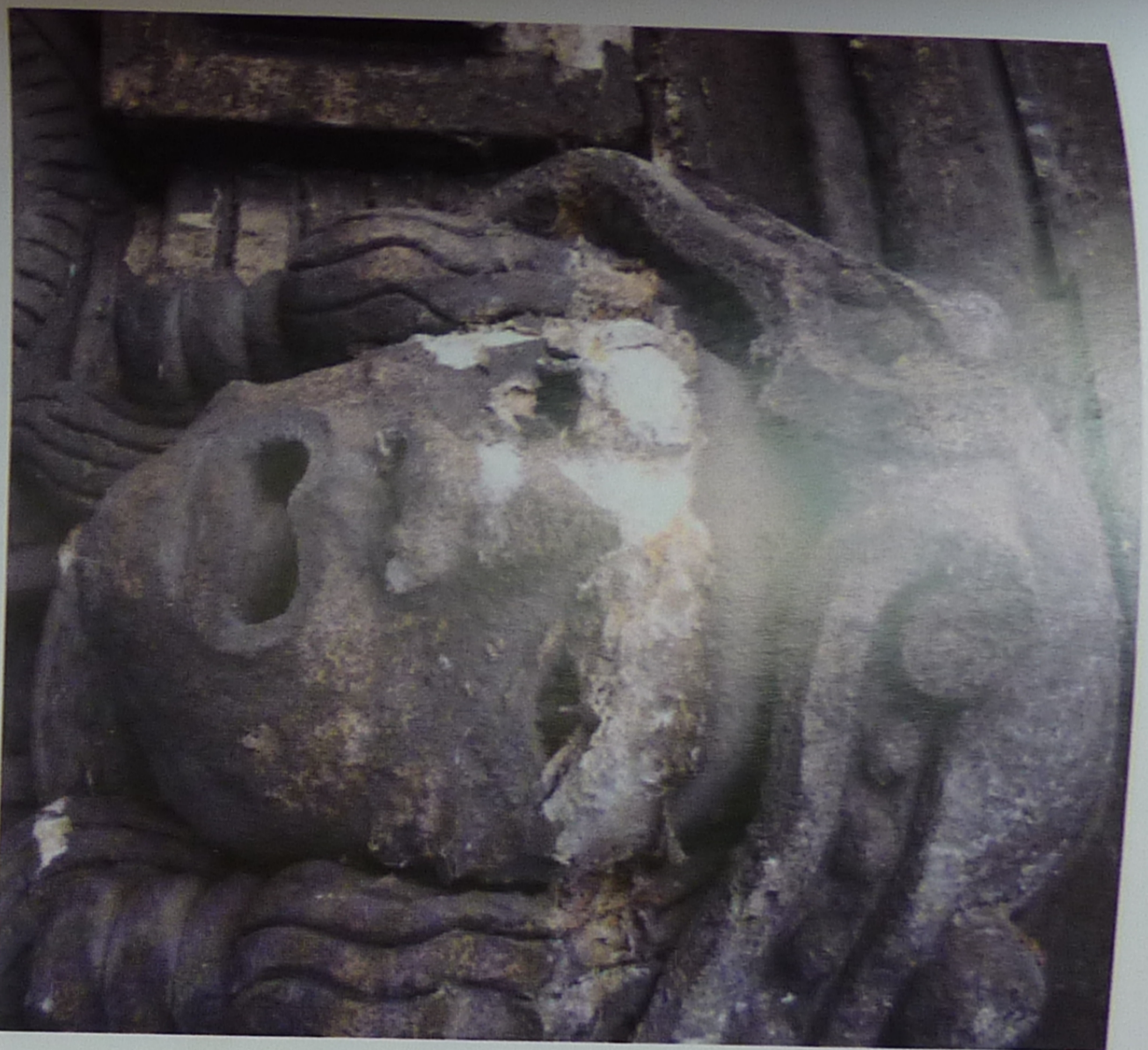
13.41. ábra. Fekete leváló mállási kéreg alatt feltáruló fehér durva mészkő (BME központi épület, főhomlokzat)
