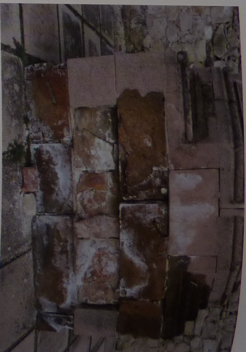
13.46. ábra. Sókivirágzás a tufa gyors kőzetpusztulását eredményezi (egri vár)
