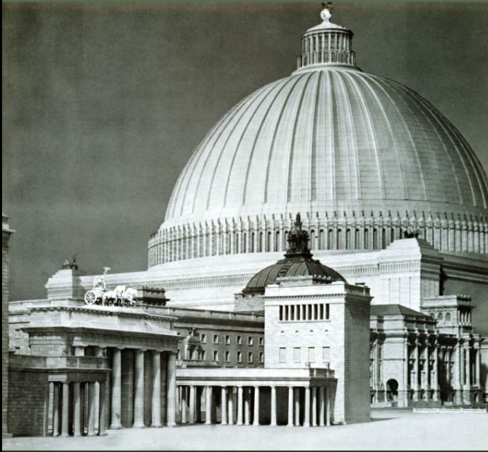
Albert Speer: A Nagy Csarnok, Berlin, 1937-1940. (A kupola átmérője 140m, felső záródása 220m magasságban. A lanterna 46m átmérőjű, nagyobb, mint a Szent Péter bazilika kupolája, vagy a Pantheon.)
