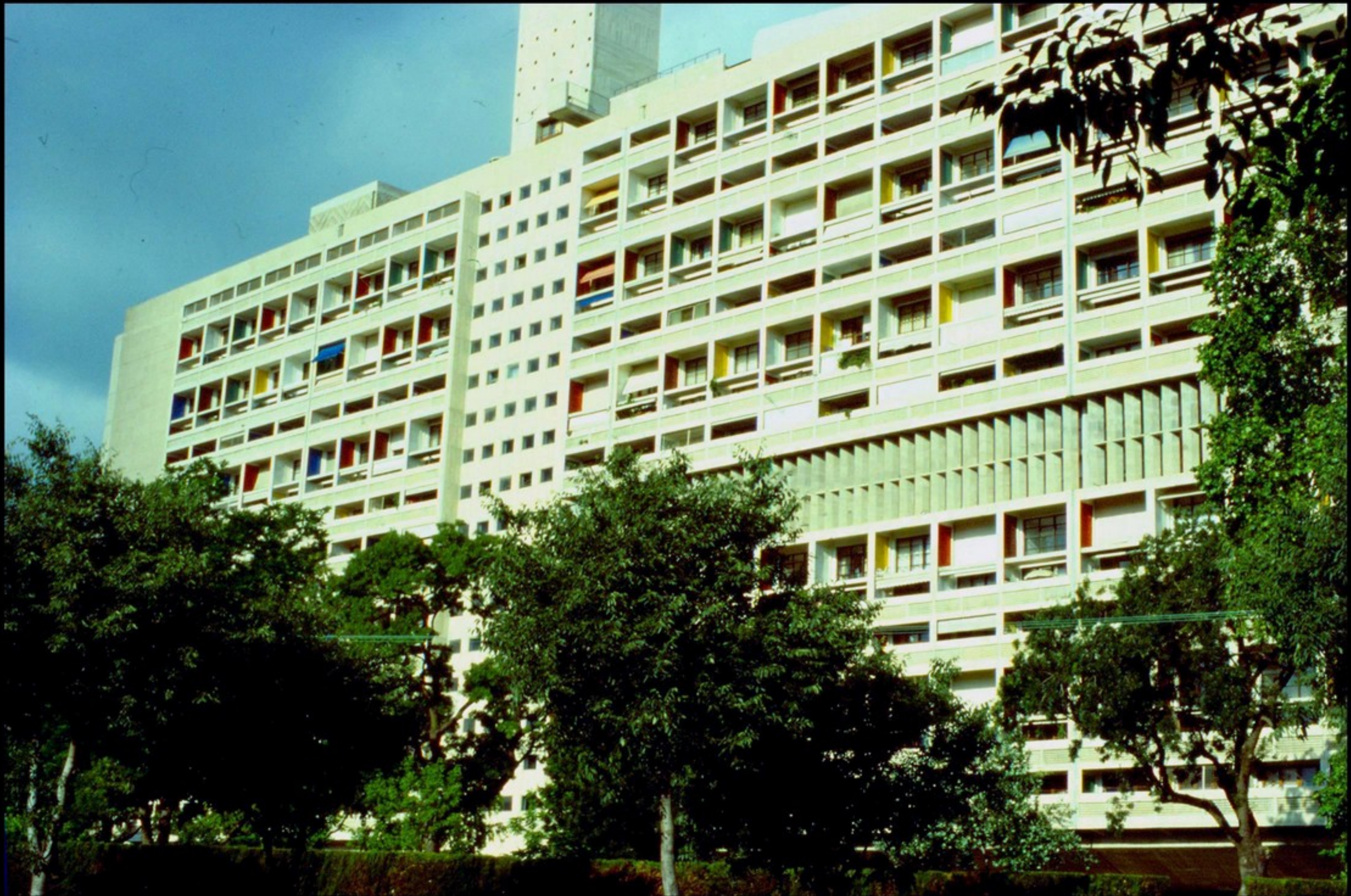
Le Corbusier: Unité d'Habitation. Marseille 1947-1952
