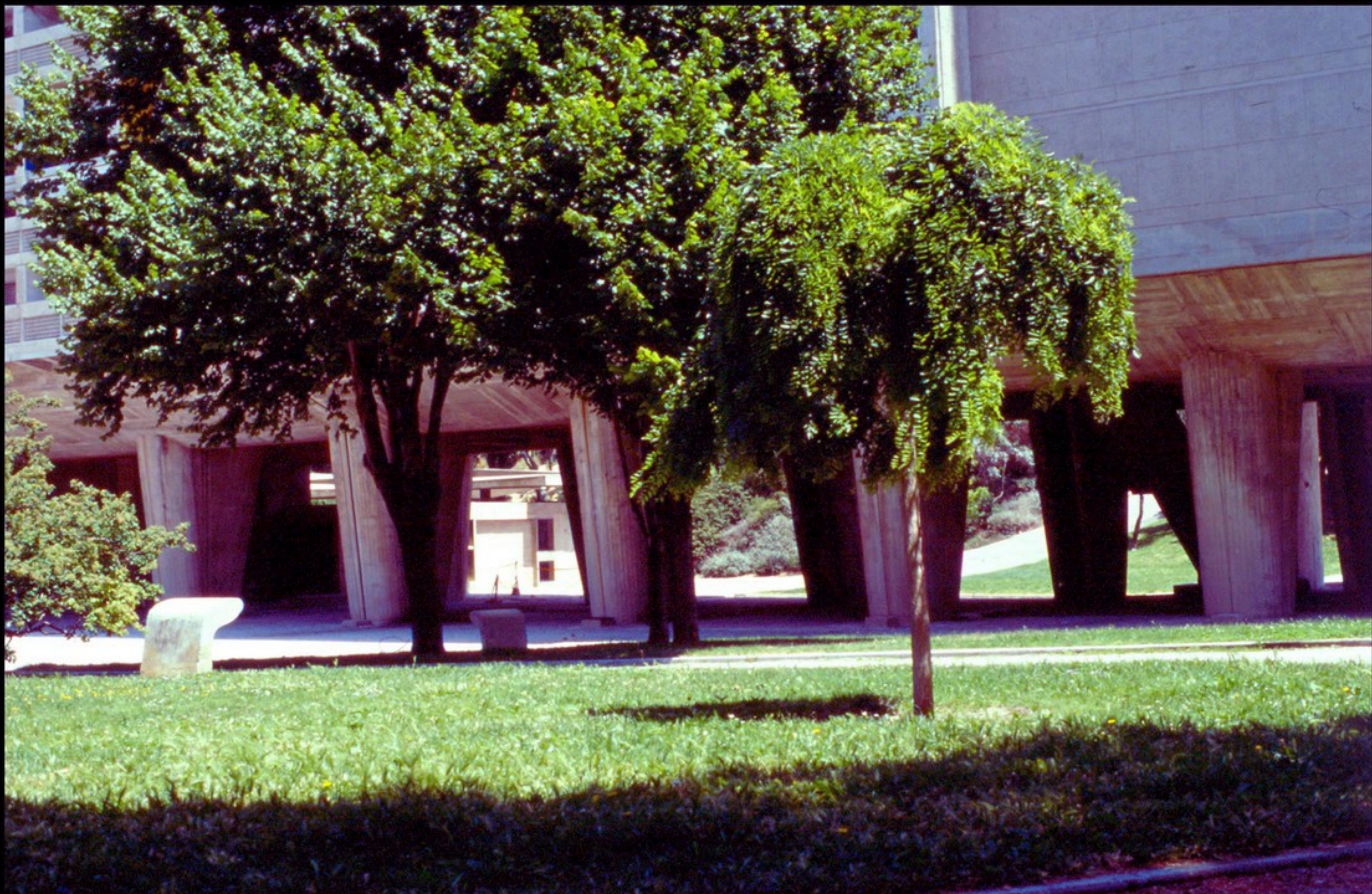
Le Corbusier: Unité d'Habitation. Marseille 1947-1952
